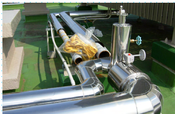
▲高架方式から加圧給水ポンプ方式に変更したため、揚水管と給水管が屋上高架水槽直下でバイパス化されている
