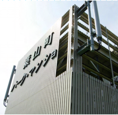
▲地震によって、屋上高架水槽が破損。マンション住民への生活水が止まってしまった
