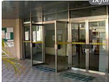
▲①エントランス改修
