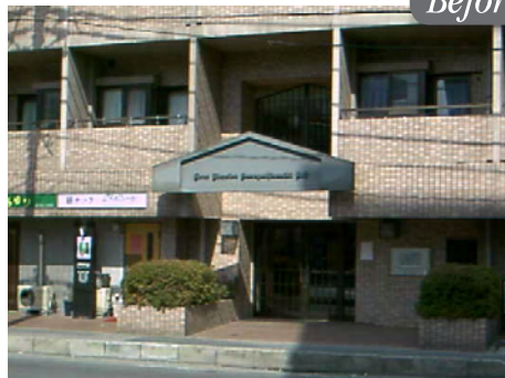
▲③外観改修
