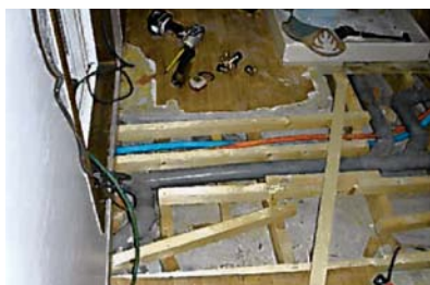
▲専有部内の床を壊して給水給湯管を更新する。全戸行うことで大規模修繕工事として修繕積立金を使って施工(内装の復旧も含む)する
