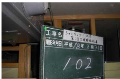
▲ダクト清掃時に発見されたダクト配管が接続されていなかった換気扇
