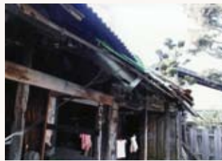
◀旧稲葉家の棟割長屋。まもなく解体される
