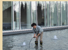
照明器具不具合の報告を受け、状況を確認中！
