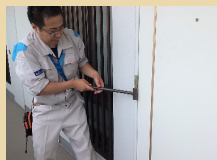
熊本での開閉難ドア調整。元建設会社の営業です！
